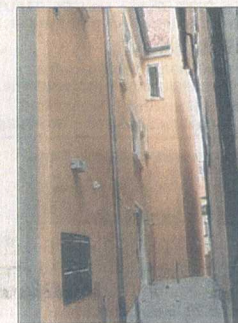
Der Zugang zu den Wohnungen erfolgt nun nach der Sanierung über die Kirchplatzgasse.
