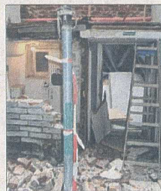
Fast kein Stein blieb beim Umbau und der Modernisierung mehr auf dem anderen (Bild) - doch davon ist jetzt nach der Fertigstellung des Wohn- und Geschäftshauses nichts mehr zu sehen.
