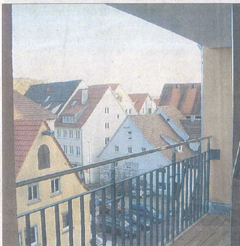
Völlig neu sind die Loggien. Sie sorgen für weitere gute Wohnqualität und zusätzlich Licht in allen Wohnungen.
