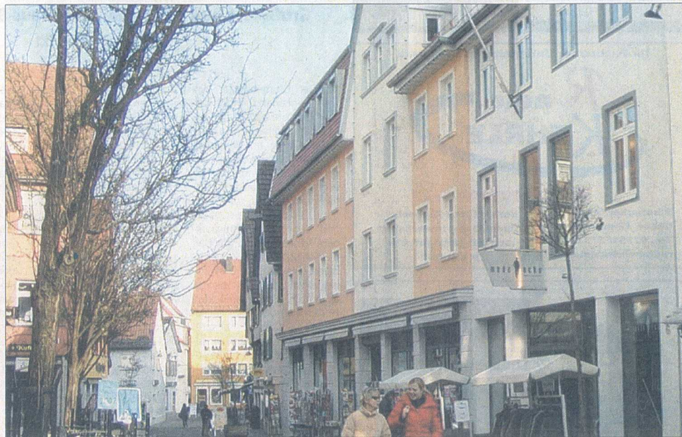
Eine Bereicherung für die Bürgerturmstraße ist das jetzt völlig modernisierte Gebäude.
